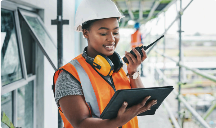
Coordinación del vaciado de losa · nivel 7
